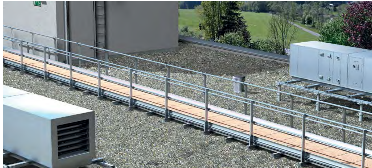
Die Auflast durch den Plattenbelag sorgt für die Standsicherheit des Systems
