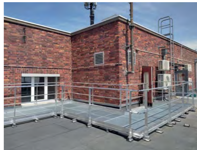
Durchdringungsfreie selbsttragende Konstruktion
